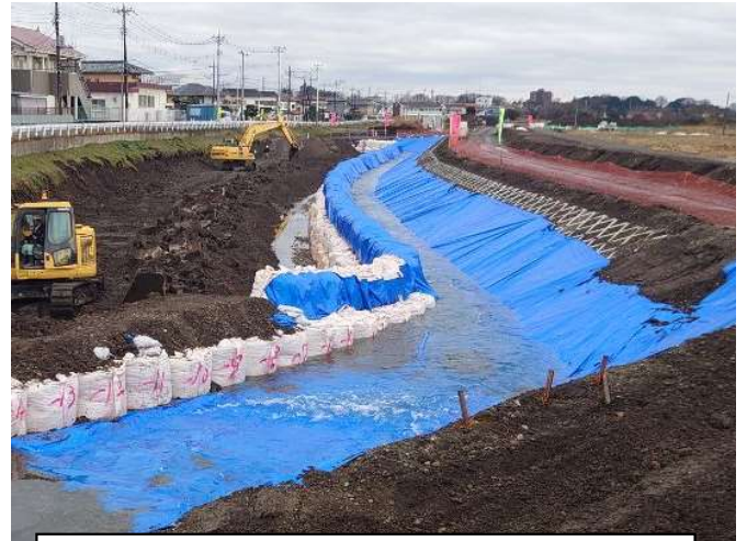
河道を切り替え左岸側築堤工事を行う様子
