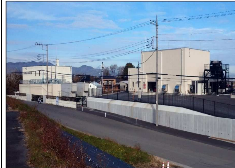
杣井木川排水機場 外観
