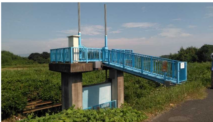
写真 7-3 横倉雨水幹線の流末の水門
