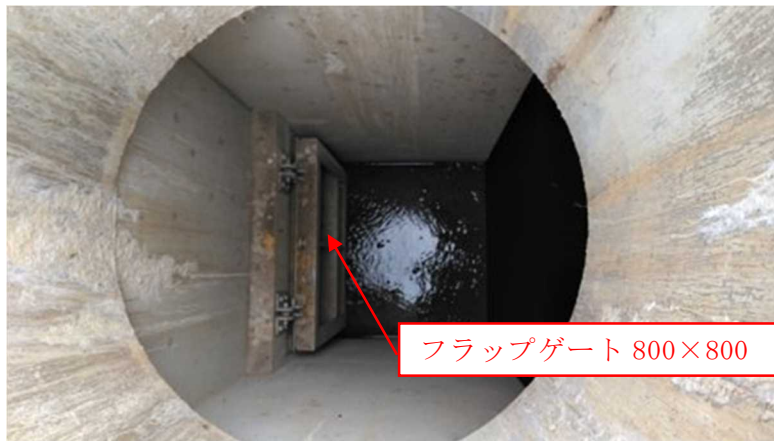
写真 7-1 放流部マンホール内のフラップゲート 800×800mm
