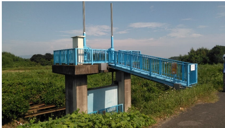
写真 2-1-3 横倉雨水幹線の流末の水門
