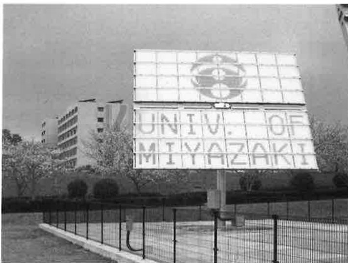
参考写真：宮崎大学設置システム（9.1kW(CSTC)/基：2014年3月完成）
