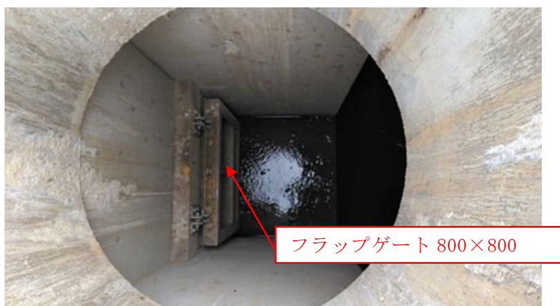
写真 7-1 放流部マンホール内のフラップゲート 800×800mm
