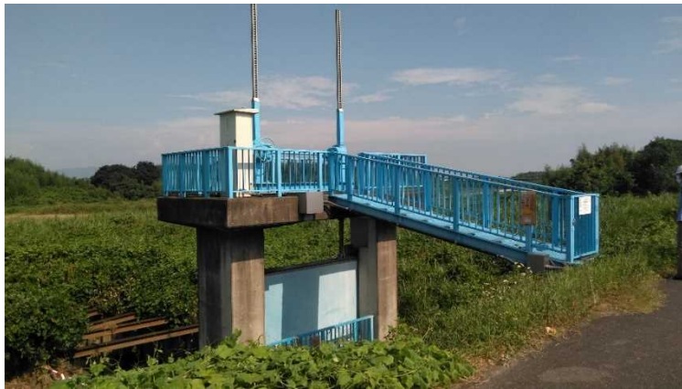
写真 7-3 横倉雨水幹線の流末の水門
