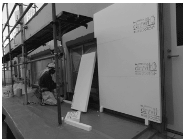
外断熱改修例
