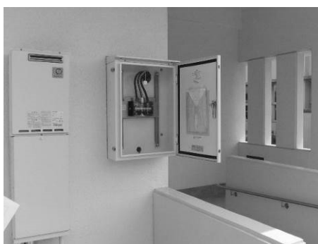
屋内運動場への接続用端子盤設置例
