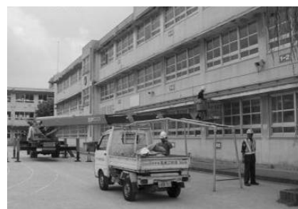
専門業者による定期的な点検
