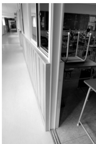
腰壁への断熱化
