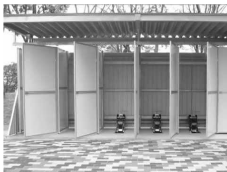
普段は駐輪場や備蓄倉庫として利用できる災害用トイレ設置例
