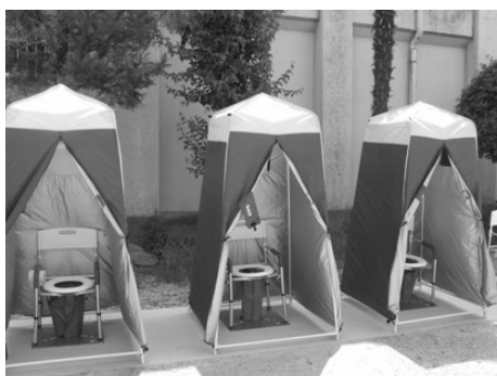
マンホールトイレの設置例
