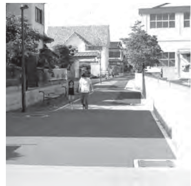
【通学路・生活道路の安全性確保】
