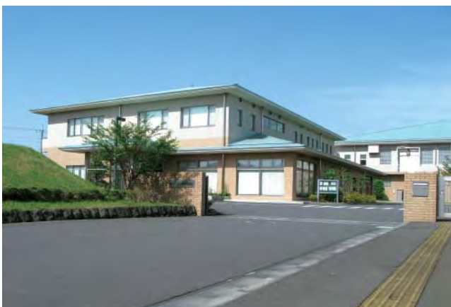
小山広域クリーンセンター
