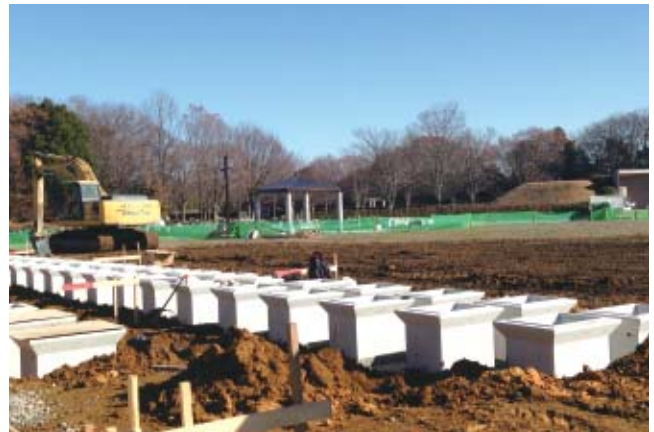
小山市墓園やすらぎの森「第16墓所区造成工事」
