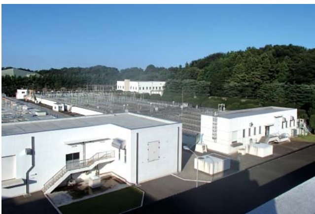
小山水処理センター
