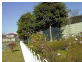
全面に豊かな緑化空間を設けている擁壁
