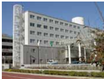
外階段を螺旋状にデザインし、ルーバー状の覆いを施した例
