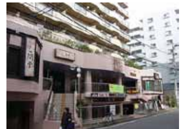
建物内店舗へのアプローチとなる外階段を建物デザインに組み込んでデザインした例
