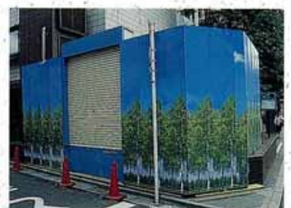
緑をモチーフにした仮囲い
