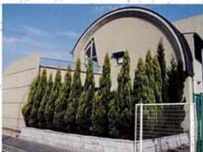
ポンプ室まわりを緑化している
