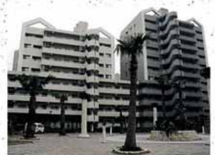
外階段を建物と一体的にデザインしている
