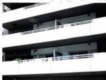
金物を低い位置に設置し、周囲からの見え方に配慮している。
