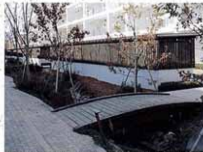
素材感を感じる駐輪場の囲いと緑地を併用している
