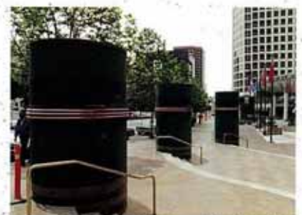
モニュメント風なデザインの地下給排気筒
