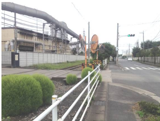
高岳引込線沿線の大規模な工場
