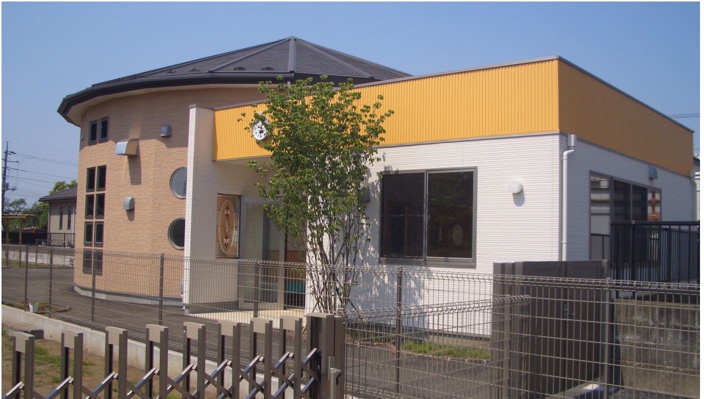
中央正面玄関、右側は事務室、左側は遊戯室
