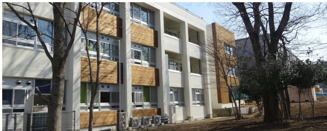
西側（ラーメン構造部分）の腰壁を杉で覆い、白いRCフレームと木の美しい対比を生み出している
