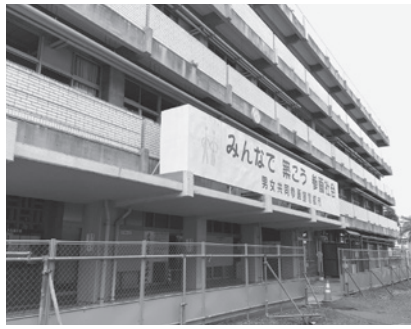
解体工事が始まる旧庁舎
