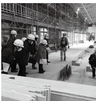
現地調査の様子(小山市立体育館)
