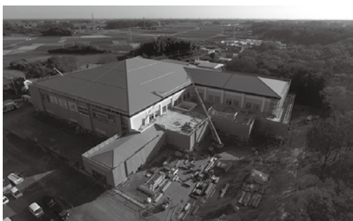
建設中の小山市立体育館
