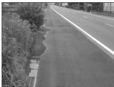
▲路肩改良による幅員確保（現況）
