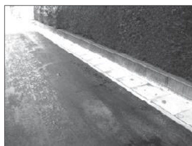
▲道路改善に併せた側溝の整備
