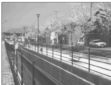
▲用水路の改修
