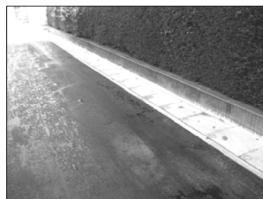
▲道路改善に併せた側溝の整備
