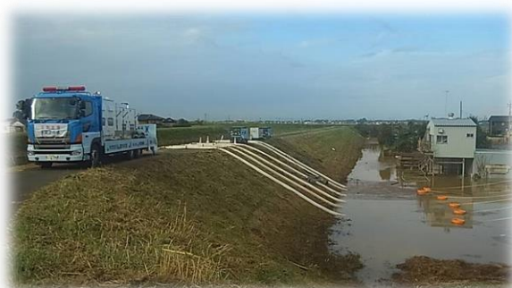
【巴波川雷電橋 水資源機構 排水ポンプ車】
