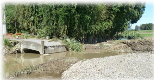
【小山市大字小宅 8-2号橋】
