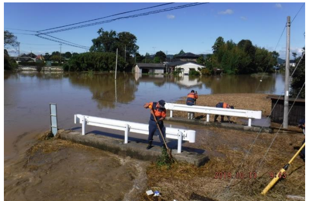
【小山市大字上泉 螢橋付近】
