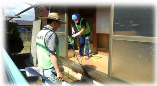
【被災者宅の清掃の様子】
