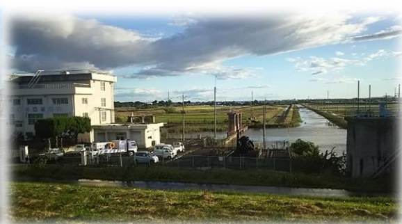
【与良川排水機場の様子】
