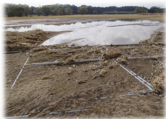
【思川緑地：土砂堆積、表土が流出した野球場の状況】
