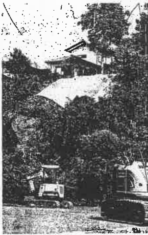
台風で崩れた住宅団地の斜面。ブルーシートなどで補強され、復旧作業が進む17日午後、鹿沼市旭が丘
