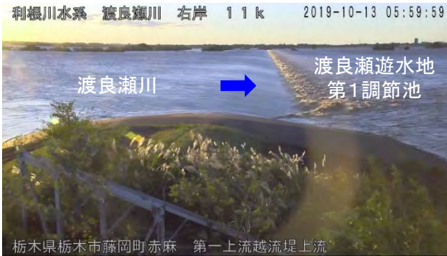
渡良瀬遊水地 第1越流堤(上流) 10月13日6時00分頃
