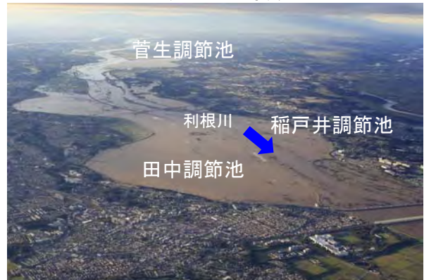
下流三調節池 上空から撮影 10月13日13時頃
