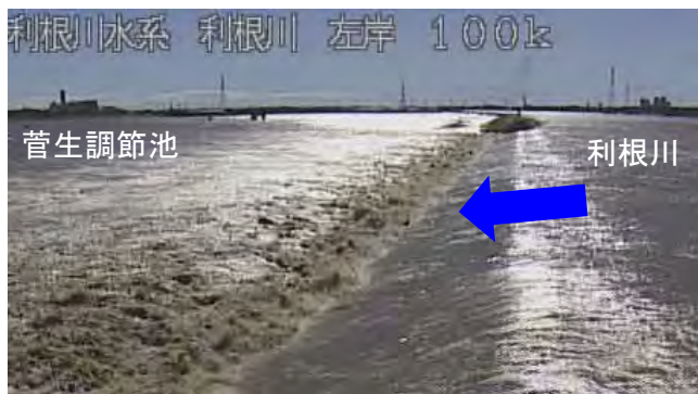
菅生調節池 越流堤 10月13日10時頃
