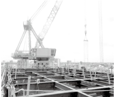
新庁舎建設の様子
