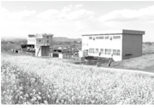
与良川排水機場 (奥:第一排水機場、手前:第二排水機場)
