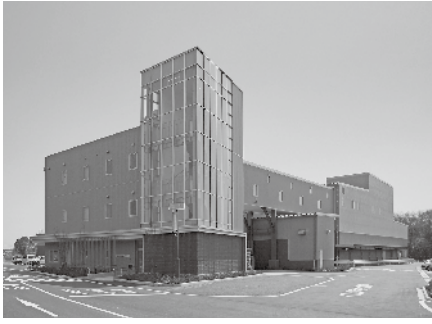
下野市に整備されたりサイクルセンター
