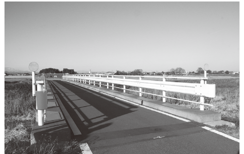
修繕を終えた本郷橋（下河原田内）
