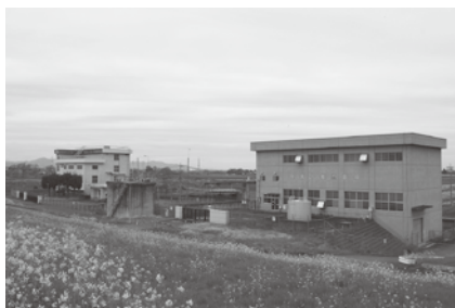
統合が予定されている 与良川第一・第二排水機場
