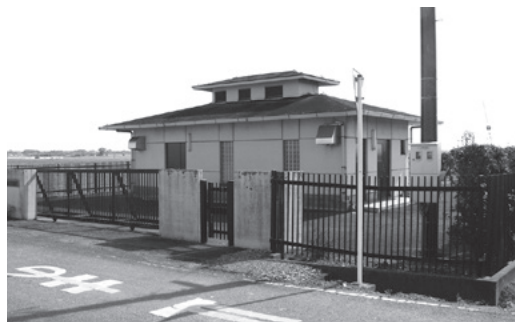
集落排水処理施設 (大字鏡地内)
