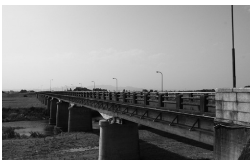
架け替えが期待される乙女大橋
