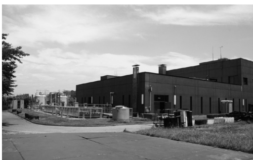
扶桑水処理センター
