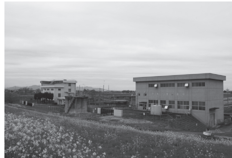
与良川第1、第2排水機場
