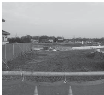
施工中の思川西部土地区画整理事業
