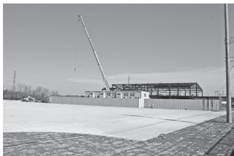
桑地区中心施設工事現場
