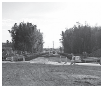
整備が進む都市計画道路 小山野木線
