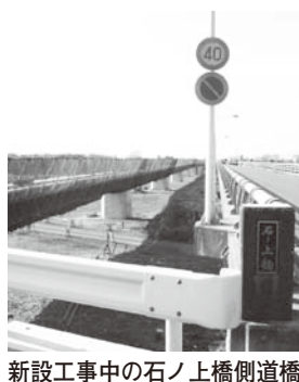
新設工事中の石ノ上橋側道路
