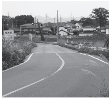
市道19号線向田橋
