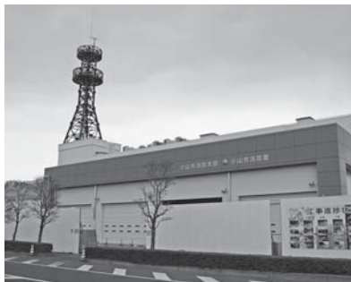
建設中の消防新庁舎
