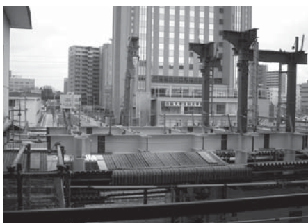
工事が進む小山駅中央自由通路
