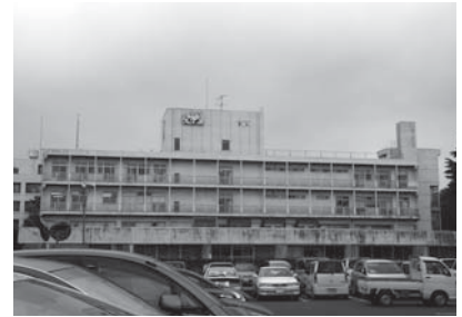
老朽化した市民病院北病棟
