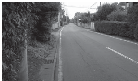
市道30号線 (東野田地内)
