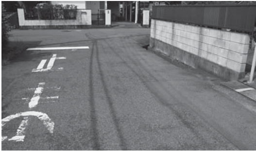
集中豪雨時に冠水する扶桑団地内の道路
