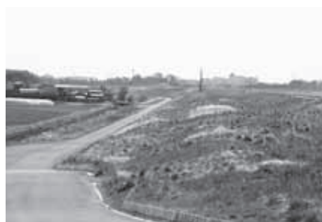
防災広場予定地（大字生井地内）
