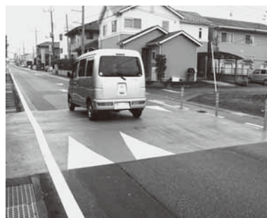
旭小学校西側市道に設置されたハンブー
