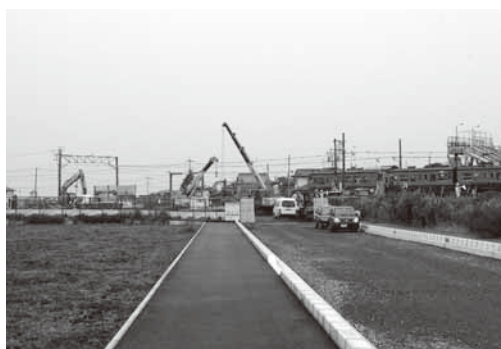
整備が進む思川駅北口周辺
