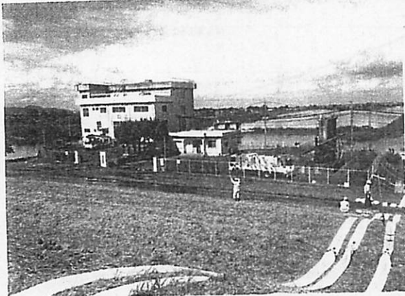
与良川第1排水機場の様子
