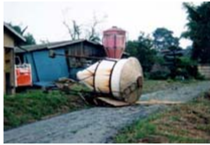
▲ダウンバーストにより倒されたサイロ ▲ダウンバーストにより壊されたトタン屋根
