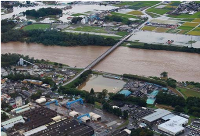
島田橋付近 (中央下方が小山中学校)
