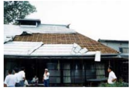
▲ダウンバーストにより倒されたサイロ ▲ダウンバーストにより壊されたトタン屋根
