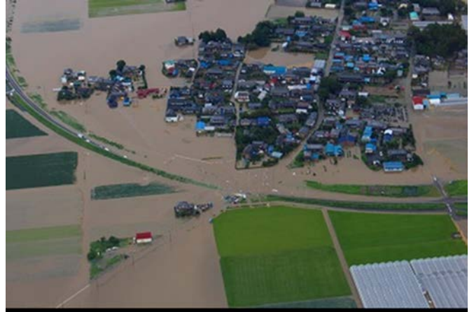
間中地区の冠水状況（中央は新間中橋の西側信号） 県道萩島白鳥線・小山環状線
