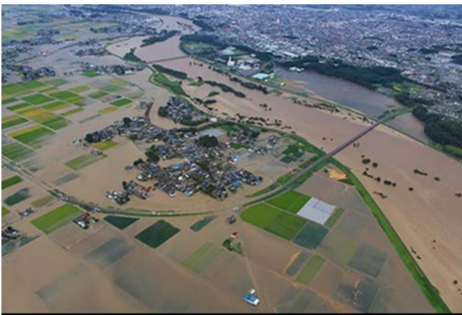
間中・塩沢・石ノ上地区の冠水状況（右手は新間中橋）
