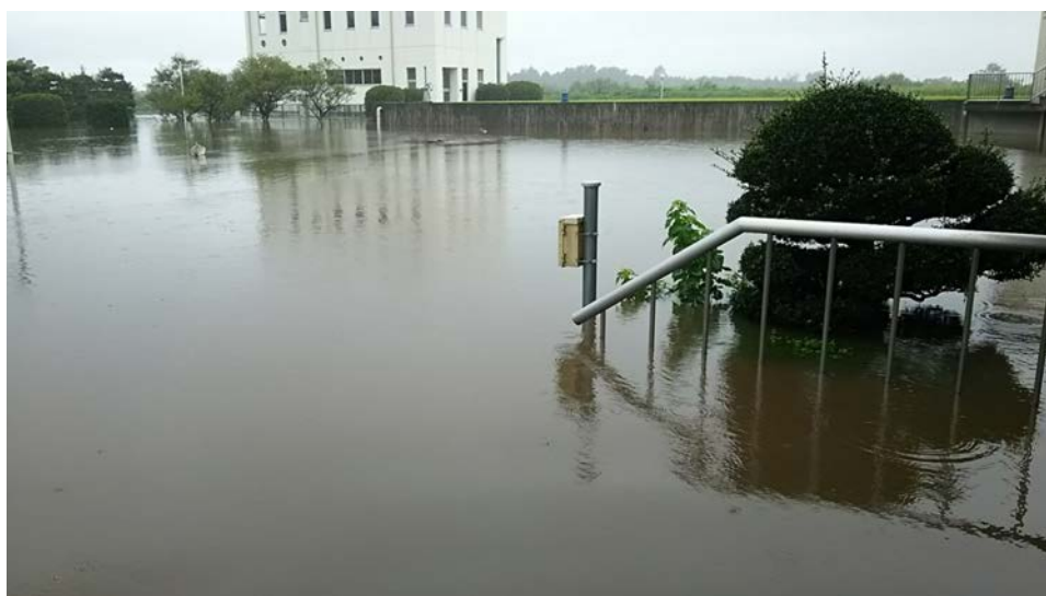
羽川西浄水場敷地内の模様
