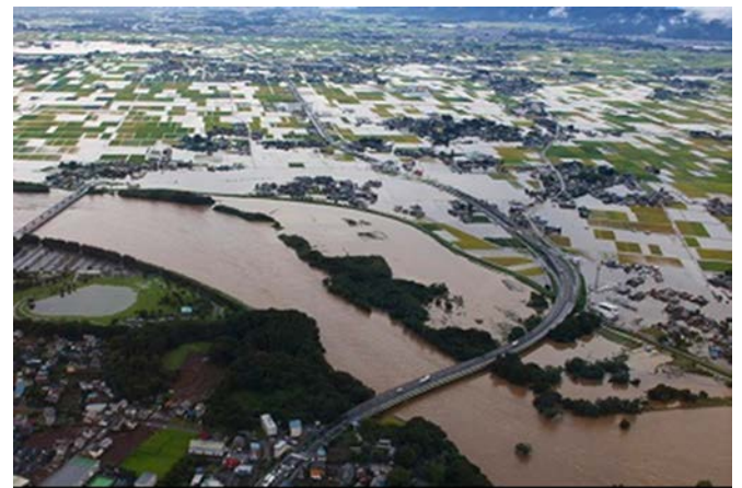
石ノ上地区冠水状況（石ノ上橋が左側）
