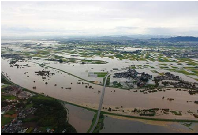
思川と間中付近の状況（中央が新間中橋）
