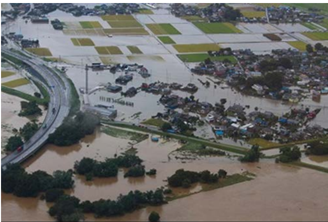
小山大橋上流右岸の冠水状況（大行寺地内県道小山結城線と思川堤防が中央）
