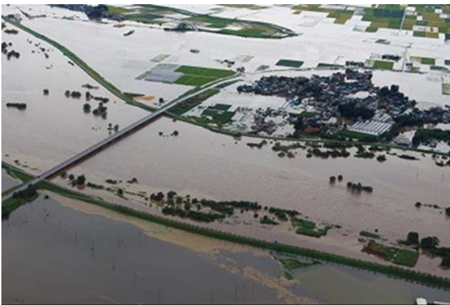
塩沢・間中地区の冠水状況（左手は新間中橋）
