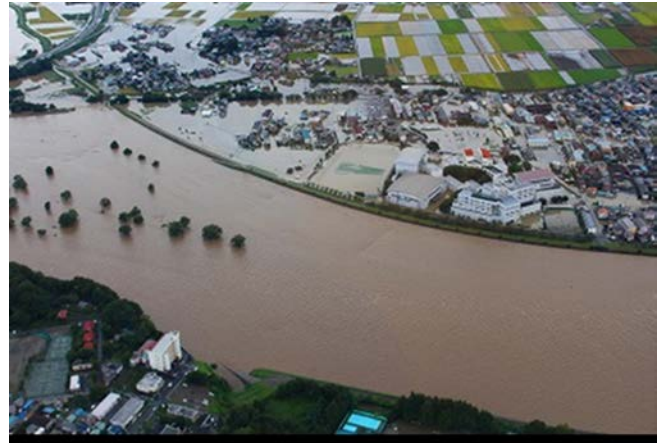
大行寺の冠水状況（白鷗大学南側駐車場が中央）
