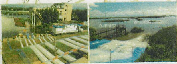
赤津川から渡良瀬第3調節池(渡良瀬川)へポンプ排水
