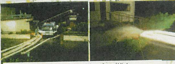
杣井木川から永野川へポンプ排水
