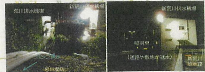
新荒川放水路から思川へ排水機場と共同してポンプ排水
