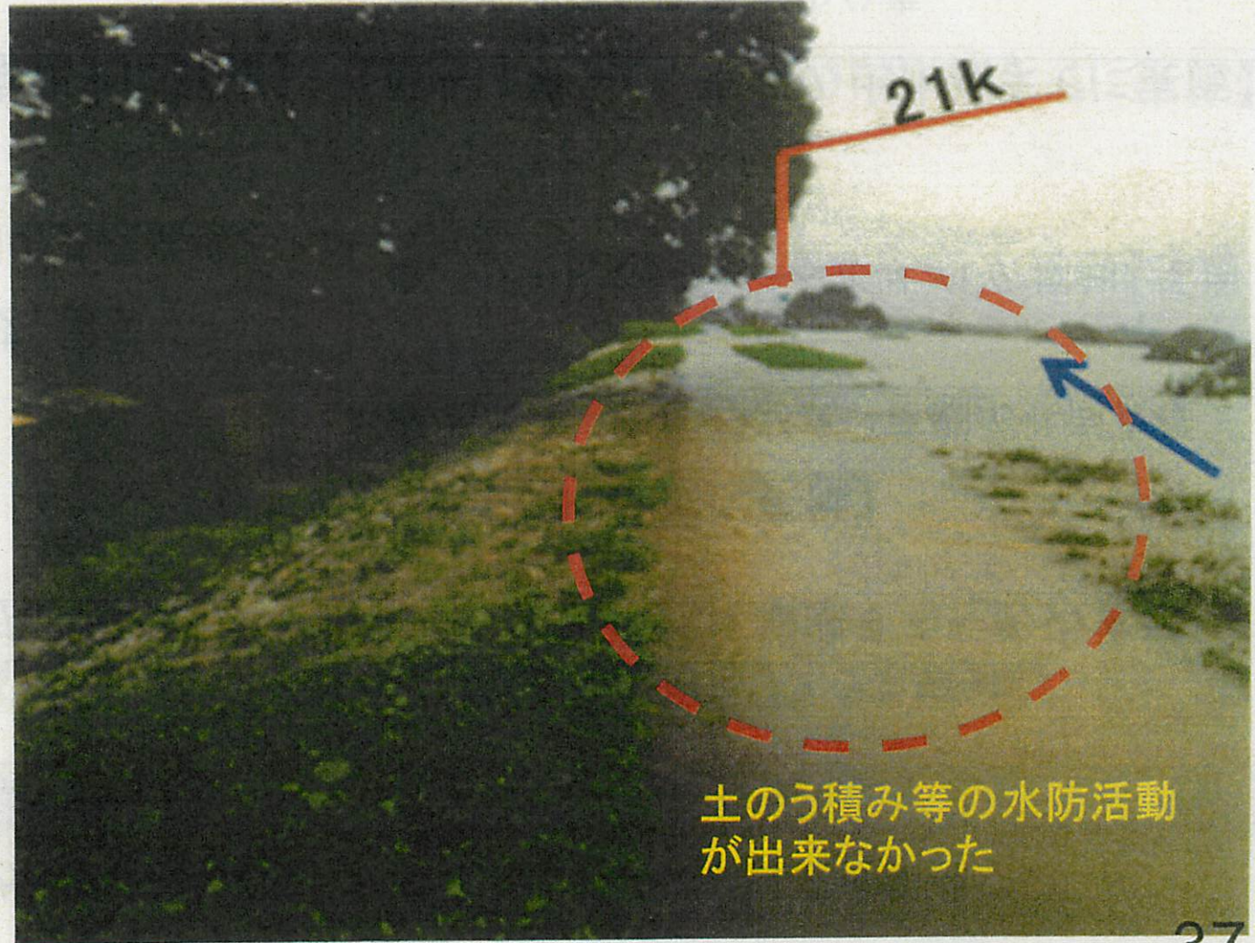
常総市三坂町地先(鬼怒川左岸21k付近)
