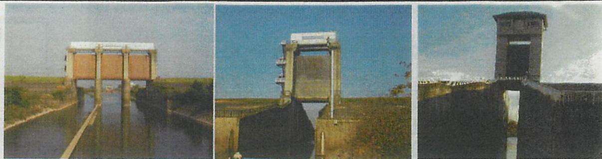
①第1排水門 (幅10m×3門) ②第2排水門 (幅10m×1門) ③第3排水門 (幅6.5m×1門)
