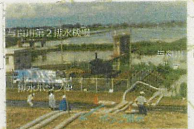
与良川から渡良瀬第2調節池(渡良瀬川)へ排水機場と共同してポンプ排水
