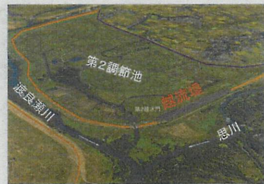
⑥第2越流堤 (延長: 790m)
