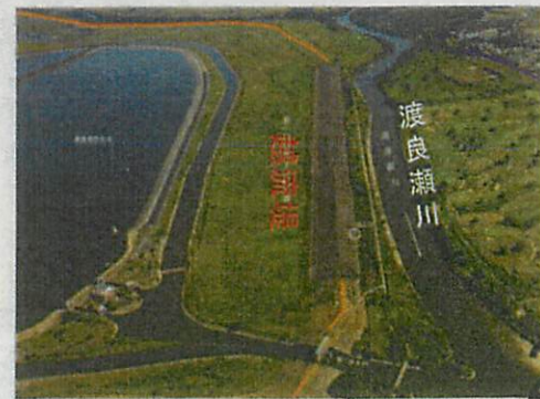
④第1越流堤[下流] (延長: 1,400m)
