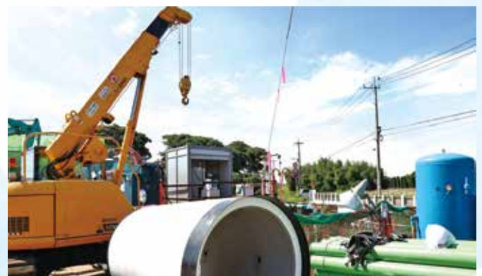
▲大行寺雨水幹線新設工事（推進工法）
