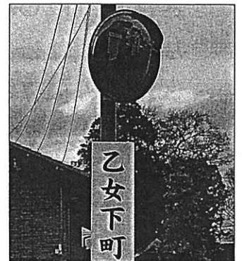
カーブミラー設置(乙女地内)
