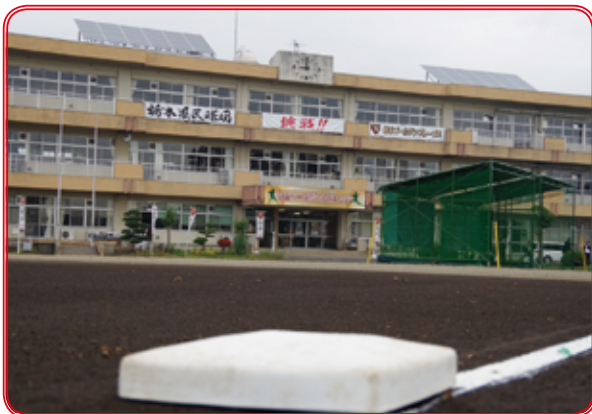
完成した小山ベースボールビレッジ (旧梁小学校)
