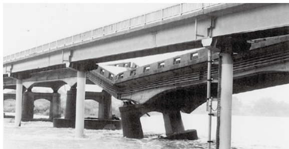
台風により崩壊してしまった橋
