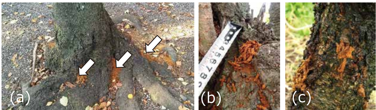
(a) さくらの株元に積もったフラス、 (b) さくらの分枝部分に溜まったフラス、 (c) ももの木から排出されたフラス
