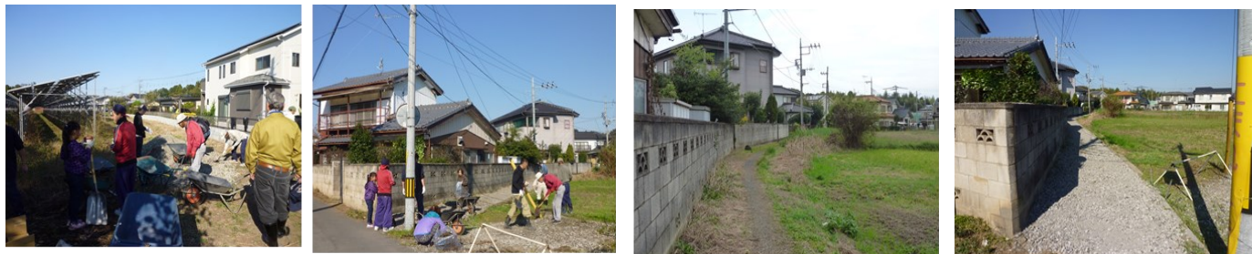
里道補修事業の様子
