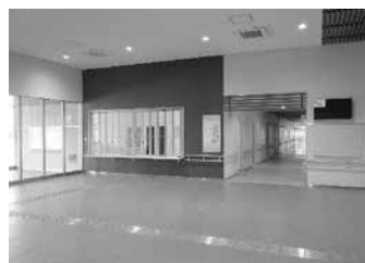
▲令和5年10月時点 開館に向け施設の工事が進められています
