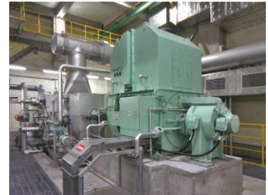
中央清掃センター蒸気タービン発電機 出典) 小山広域保健衛生組合中央清掃センターパンフレット
